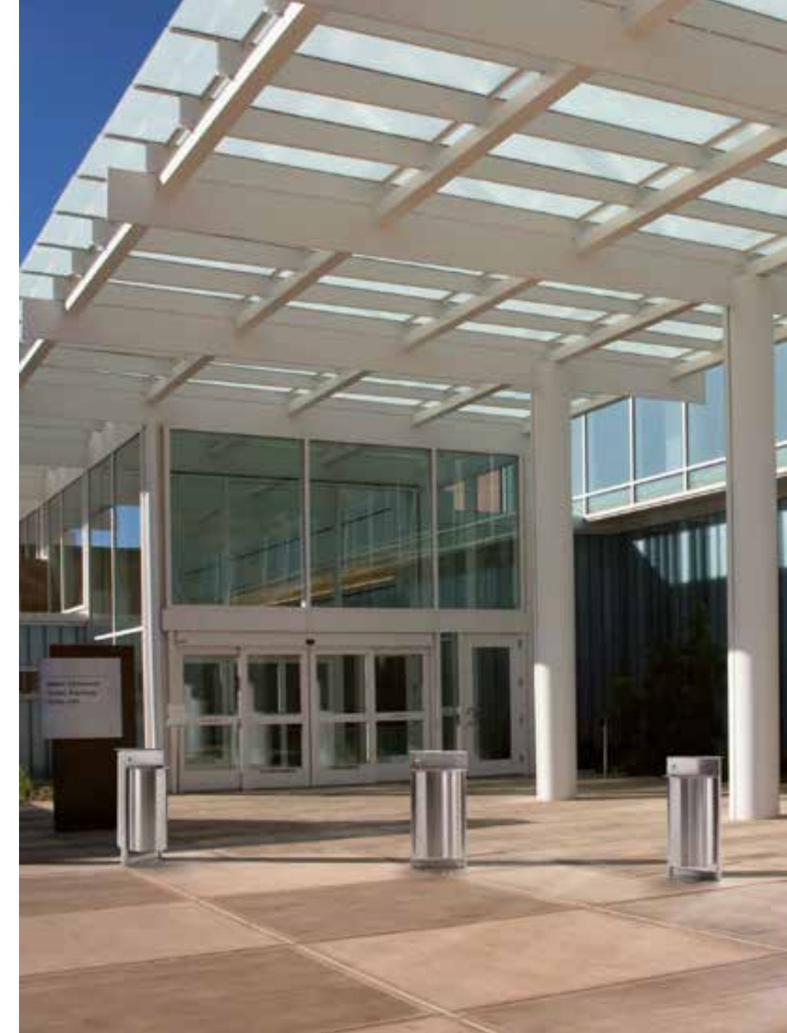
TORRE CAIMI LAB - 217
